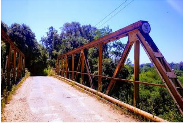
21 - Antiga Ponte de Ferro sobre o Rio Cadeia
