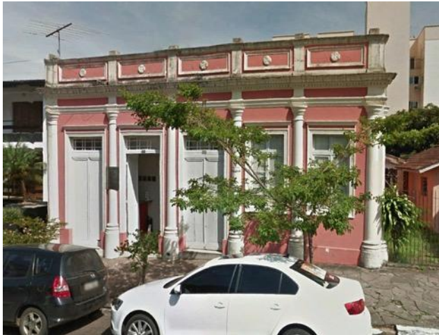
13 – Rua Marechal Floriano Peixoto, 405 – Prefeitura Municipal Uso: Institucional Justificativa: Exemplar de valor arquitetônico e histórico, localizado dentro do núcleo formador do município.
