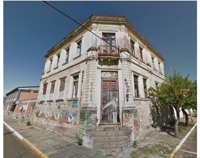
16 – Rua Gen. Câmara, 436 Sem uso Justificativa: Exemplar de valor arquitetônico e histórico, localizado dentro do núcleo formador do município.
