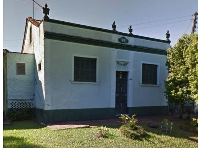
14 – Rua S/Nome (Beira-rio, entre Rua Tiradentes e Cel. Paulinho Teixeira), 146 Uso: Residencial Justificativa: Exemplar de valor arquitetônico e histórico, localizado dentro do núcleo formador do município.
